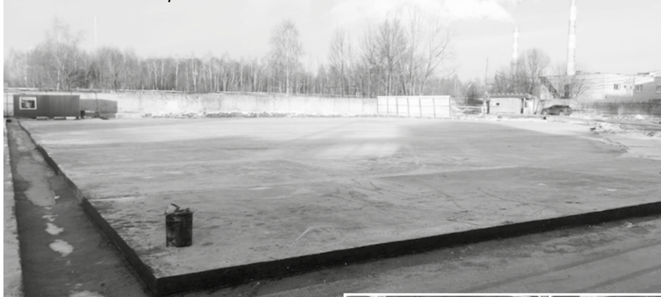
Новая бетонная площадка
